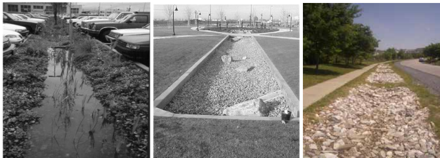
Figura 28 – Esempi di trincee d’infiltrazione
